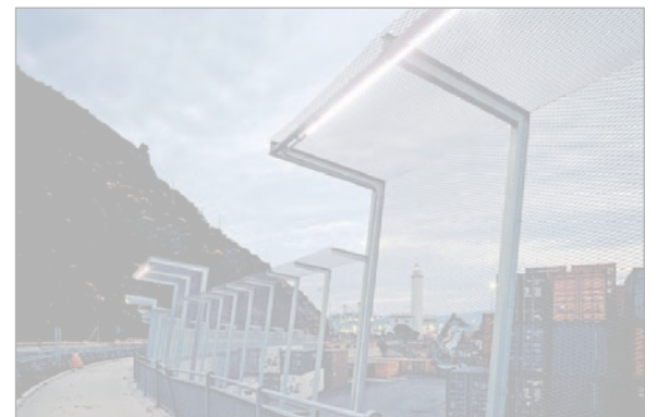
Progetto: Marco Ciarlo Associati Committente: Anas Dipartimento di Genova Direzione lavori: Ufficio tecnico Anas Localizzazione: Bergeggi (Savona) Impresa: Betombit srl Cronologia: 2008-2009 Costo: 220.000 euro
